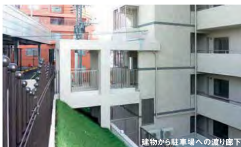
建物から駐車場への渡り廊下
